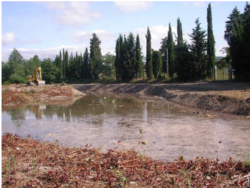
T. Stura dopo i lavori
