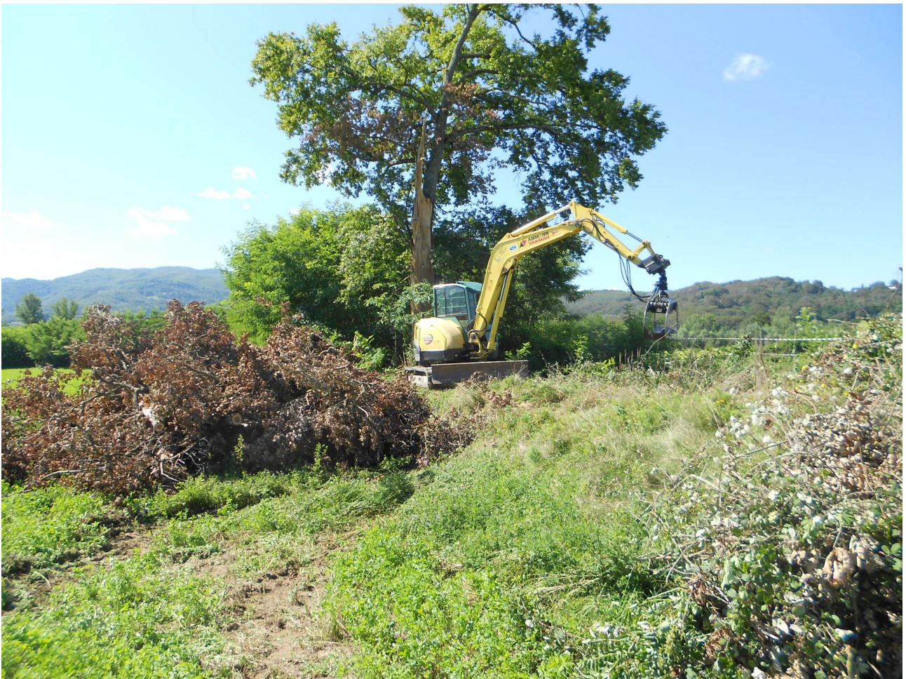
foto – Mezzo meccanico all'opera per rimuovere l'alberatura crollata (depositata a fianco) nel Torrente Pesciola
